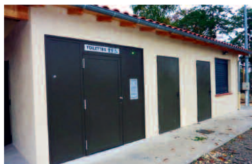
Cabine wc à usage pour tous Le Castera (31)
