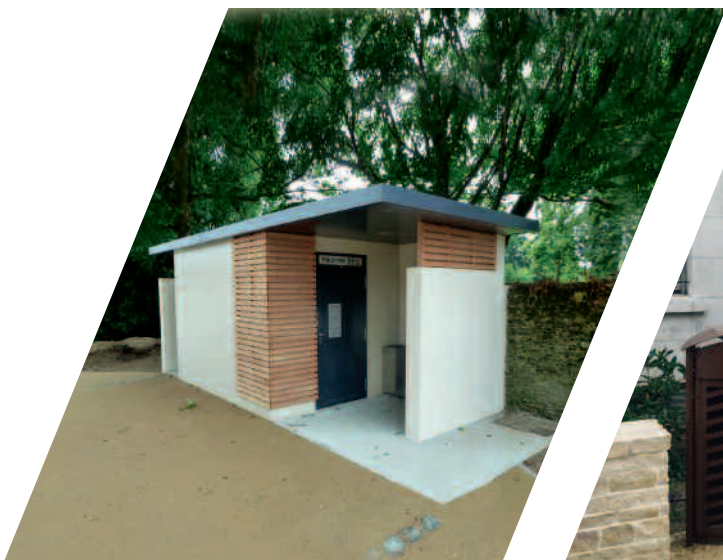
Module Spécifique (habillage Béton et Bois) - Sucé sur Erdre (44)
