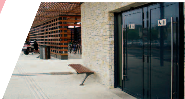
Cabine wc à usage pour tous La Baule (44)
