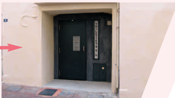
Cabine wc à usage pour tous Loriol sur Drôme (26)
